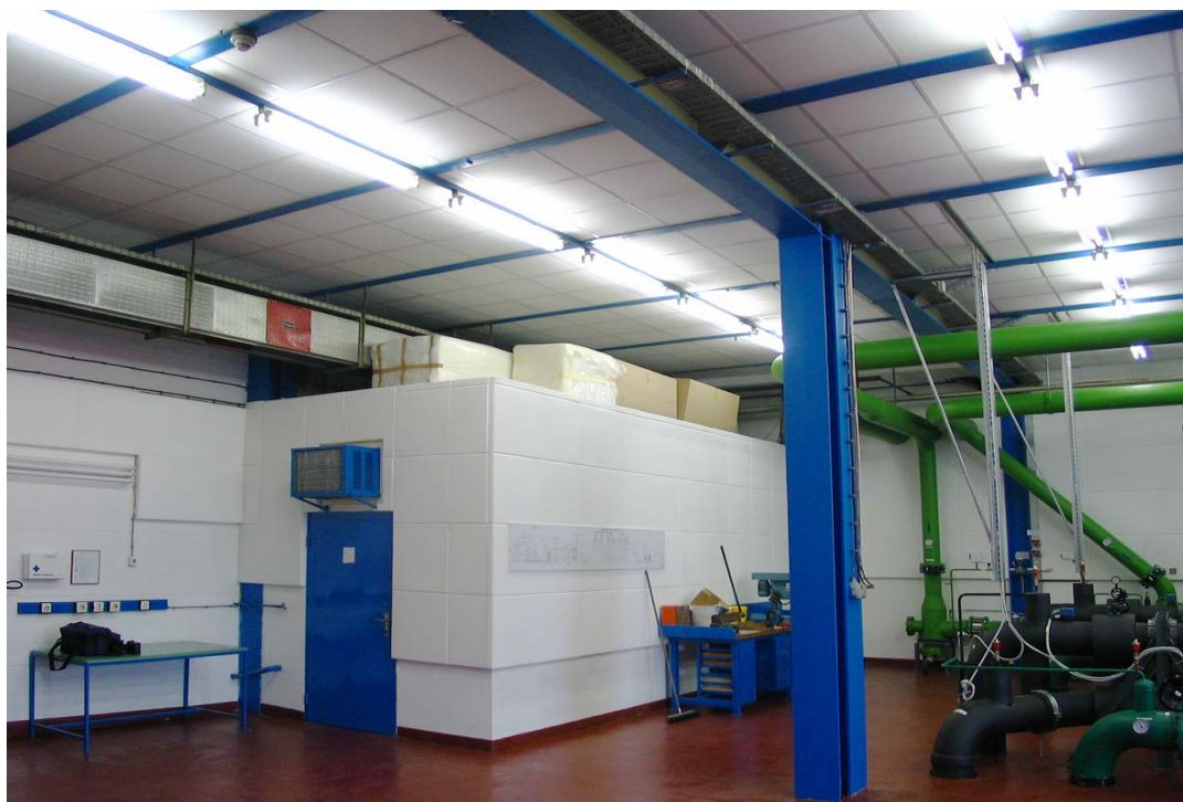
Akustične ADP plošče, nalepljene na steno strojnice
